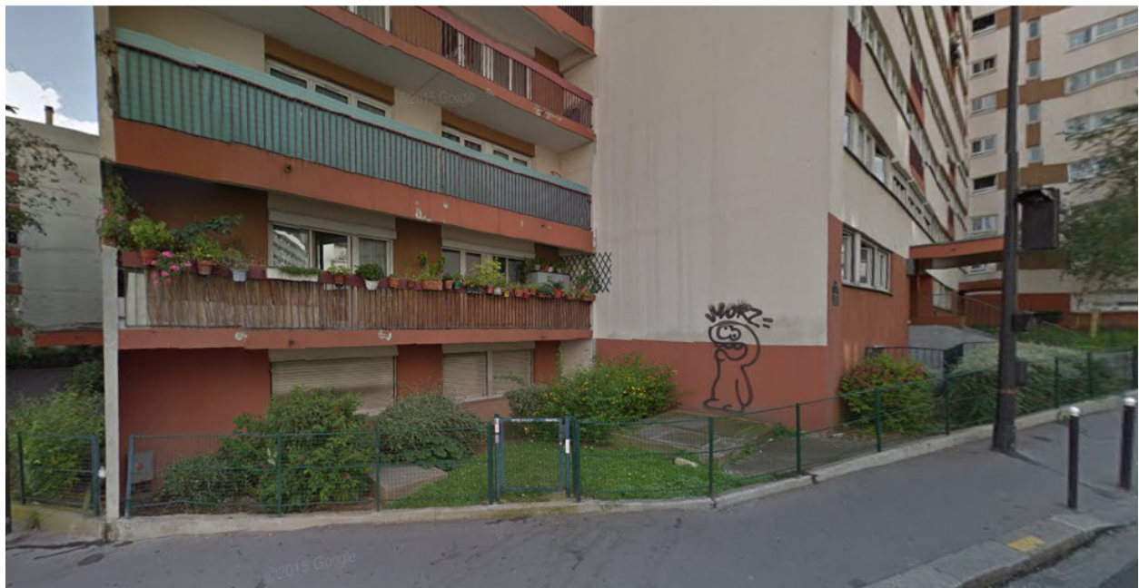
Rue de l'Inspecteur Allés, Paris
